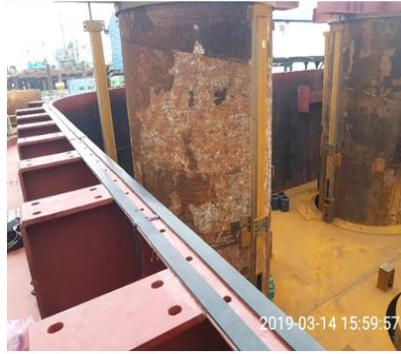
壁體接合部止水膠帶
